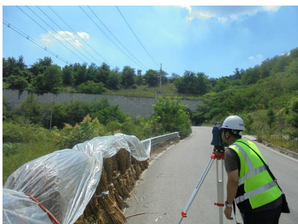
광파기를 이용한 측량 작업
